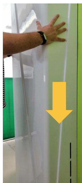
Appuyer la coque contre le mur et l'abaisser vers le sol
