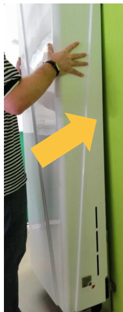
Incliner la coque et élargir légèrement le bas pour passer sur les brides de fixation
